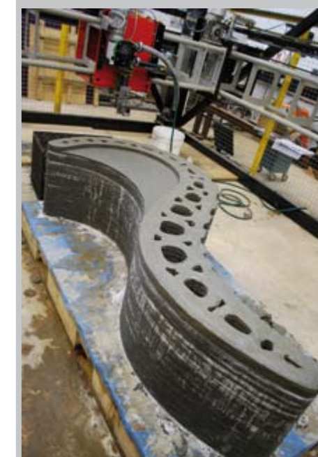
Wonderwall in opbouw (2009).
